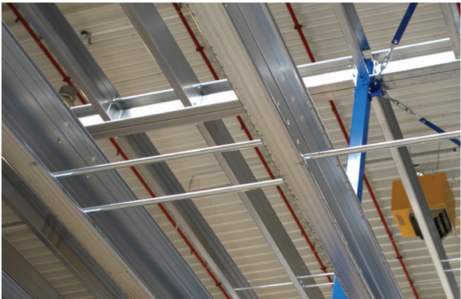
Obr. 25 – Schema umístění výztužných tyčí v případě lichého počtu stropnic
