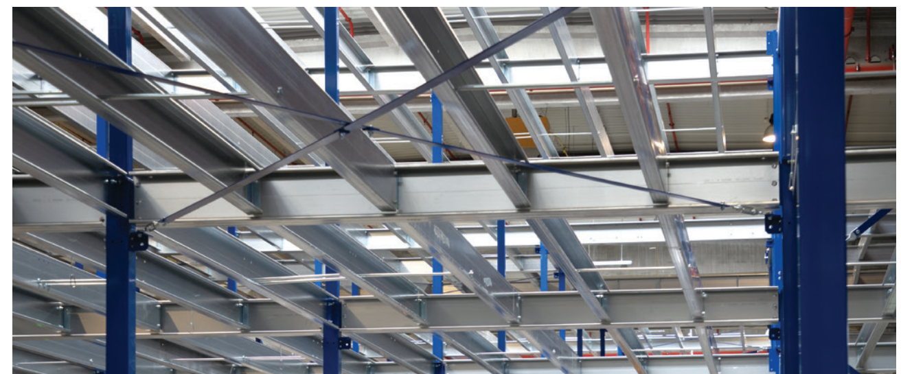
Obr. 13 – Připojení průvlaku ke sloupu pomocí jedné až tří dvojic šroubů
