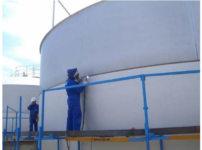
Vor-Ort-Schweißen von Edelstahltanks ist eine typische Anwendung für die Allpositionsrutillfülldrähte von Böhler Welding. Die Tanks aus 1.4162 werden mit FOXcore 2307-T1 geschweißt.
