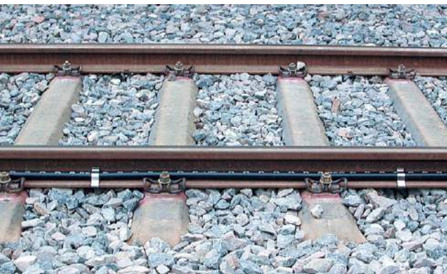
Schienenfußklammer 2 mm mit einem Kabel
