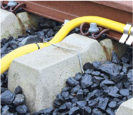
Befestigung des Kabelabzweigs mittels Schwellenklammer
