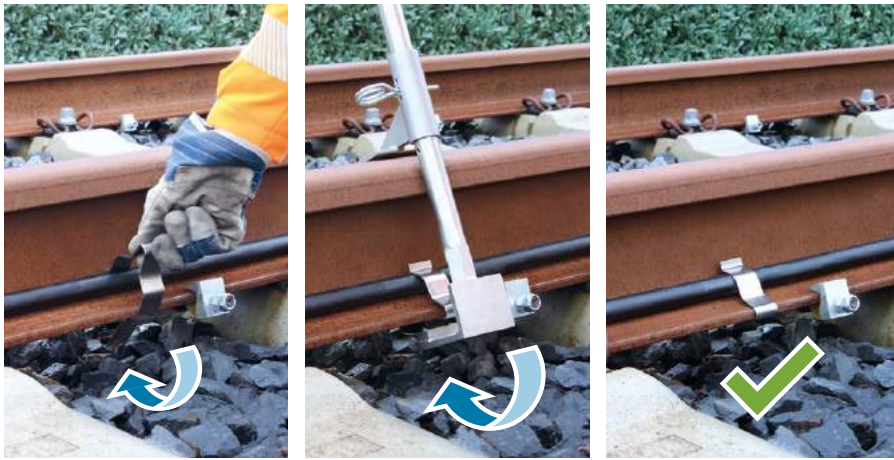
Ansetzen Aufziehen Fertig
