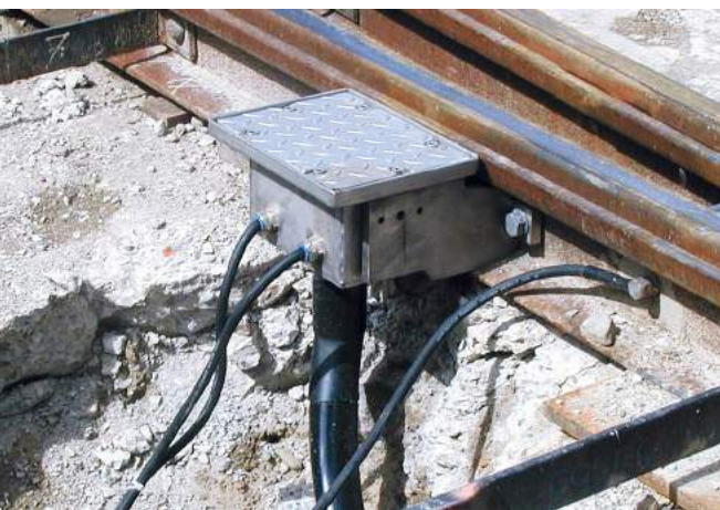
Gleiskasten montiert
