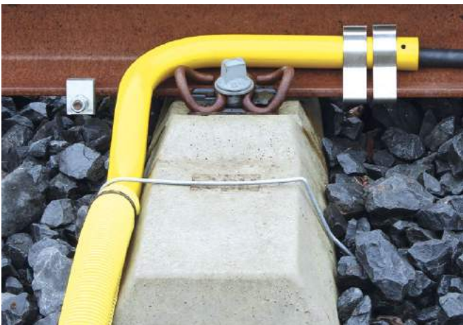
Befestigung des Kabelabzweigs mittels Schwellenklammer
