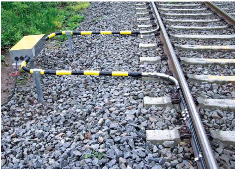
DuoTrack Mehrlängen-Muffenbaukasten
