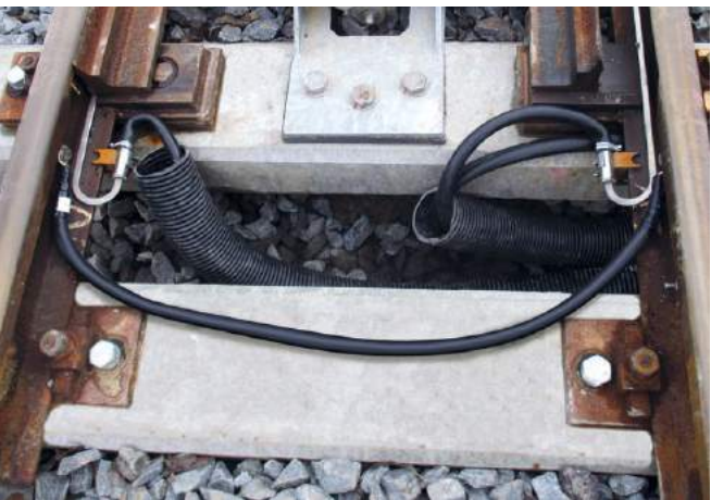
Verbinder mit Schienendoppelkontaktsystem SDK 02
