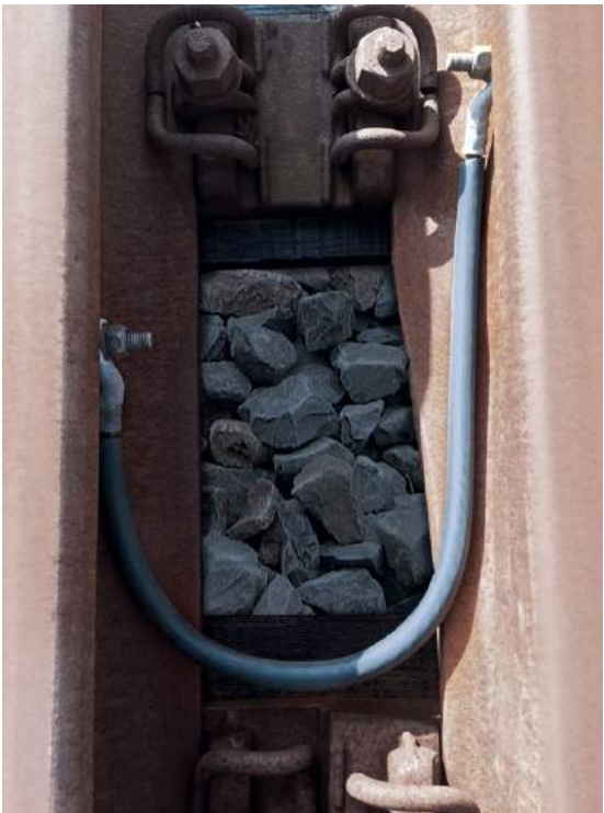
Verbinder mit Schienendoppelkontaktsystem SDK 02
