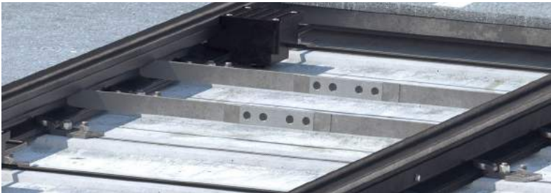
Isolierte Spurstangen im Gleis
