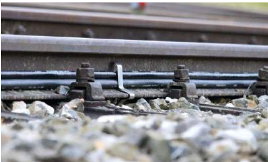
Schienenfußklammer 2 mm mit zwei Kabeln
