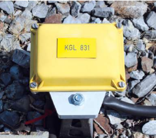
Kabelverteiler Draufsicht
