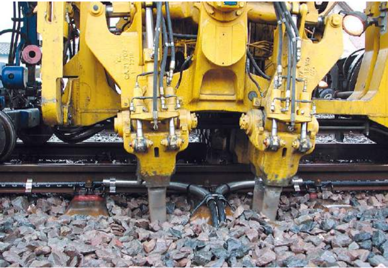
Sichere Kabelführung bei Stopfarbeiten
